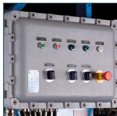
Герметичный блок управления
